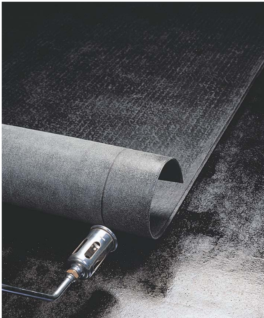
Udlægning af DERBIGUM GC med gasbrænder.
