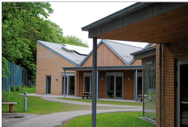
Børnehaven Humlebien er udført med isolering efter kravene i BR15 og desuden opført med solceller på taget. (Pressefoto)
