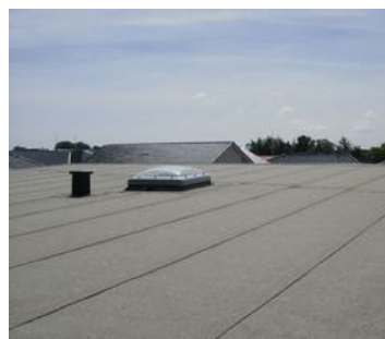
Derbigum-taget på Realdania Byggs MiniCO 2 Typehus i Nyborg.
